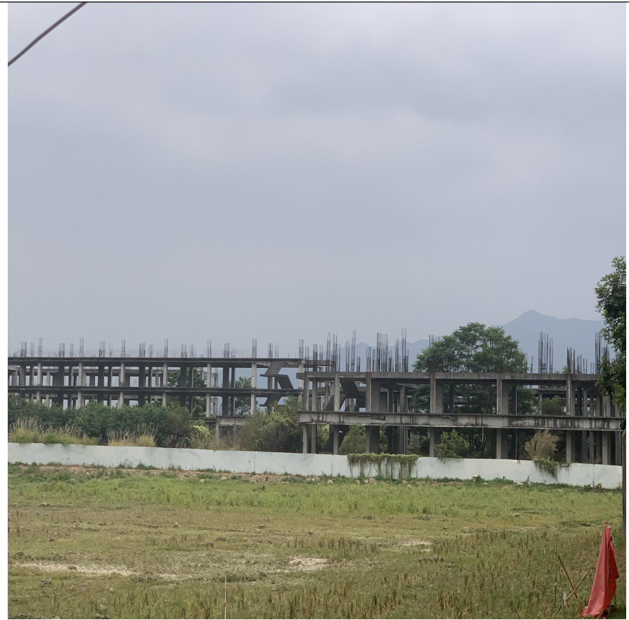
项目南侧（废弃楼）
