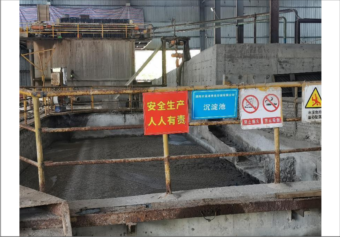
生产废水沉淀池
