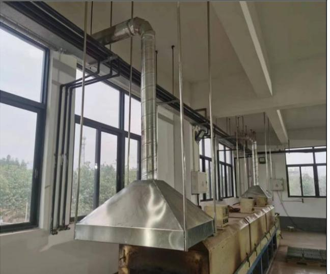
转子涂敷有机废气收集
