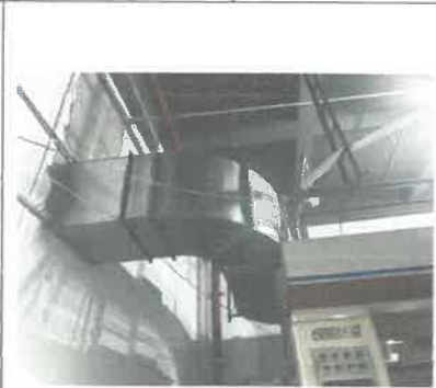
车间废气收集管道
