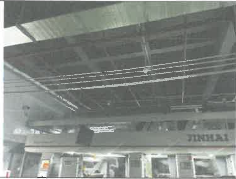
车间废气收集管道
