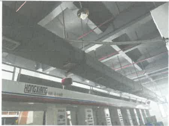
车间废气收集管道
