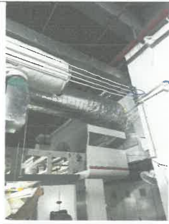
车间废气收集管道
