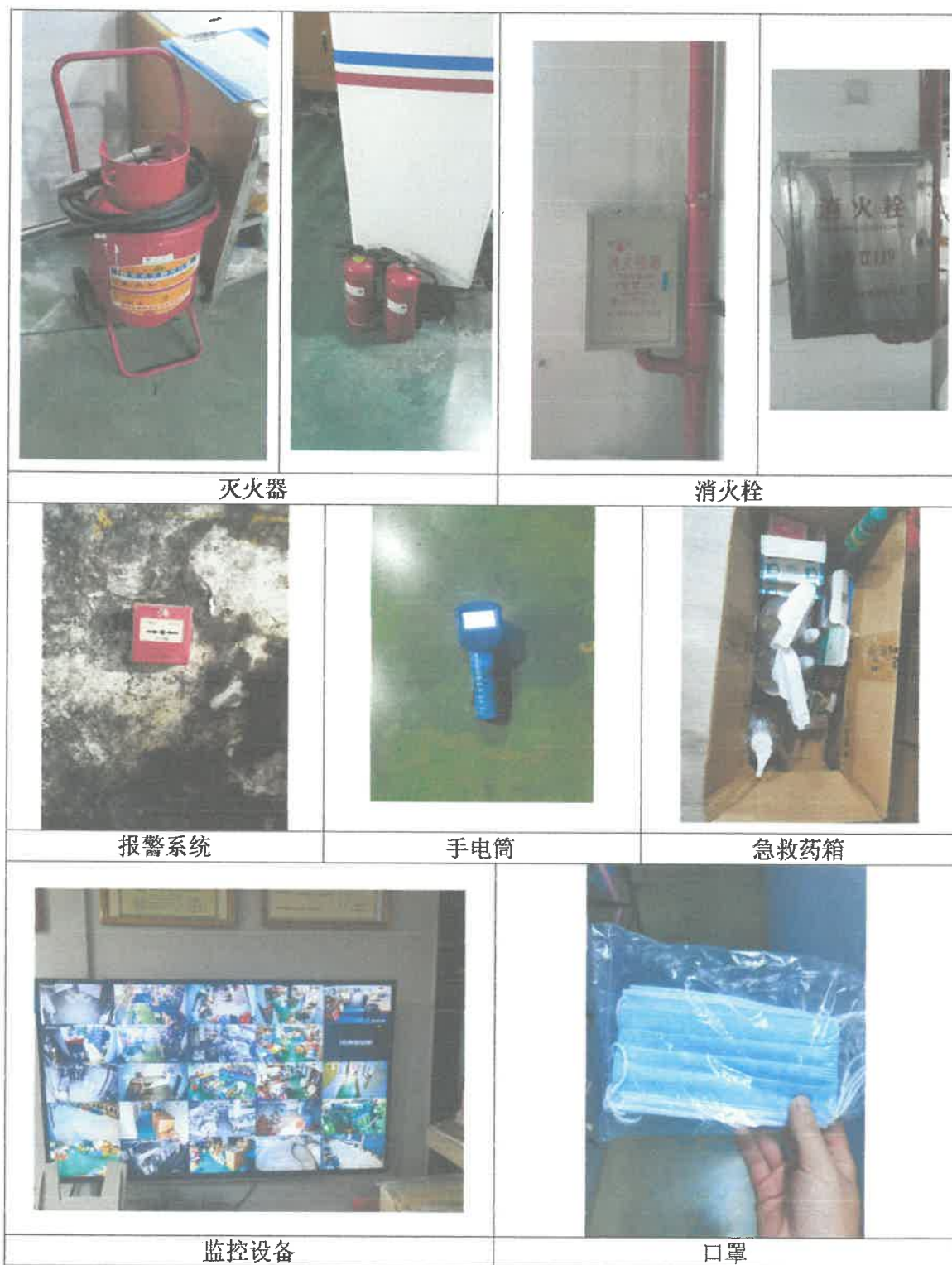
附图六 现场应急设施及环保设施图片
