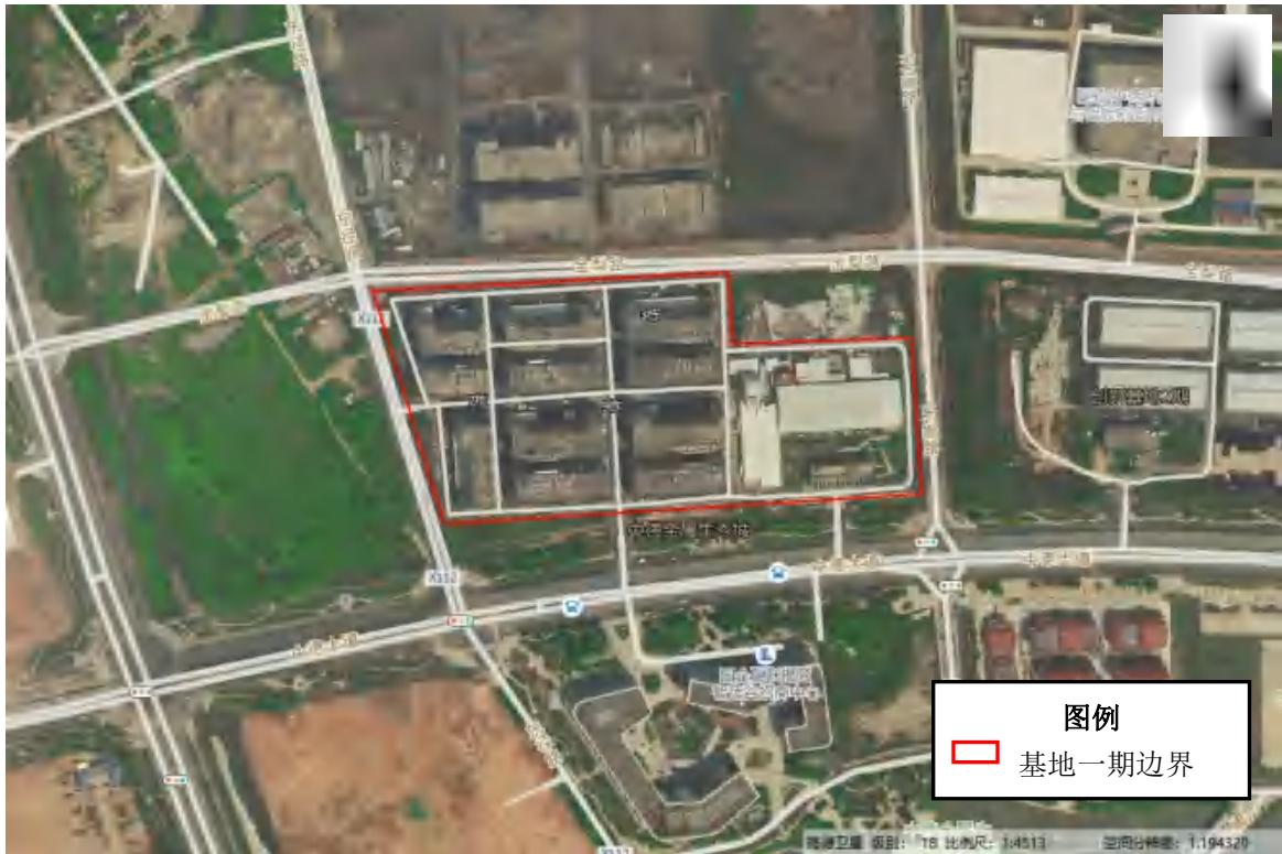
图 2.1-29 2023 年中德金属生态城首期工程（揭阳市电镀定点基地）一期项目卫星影像图
