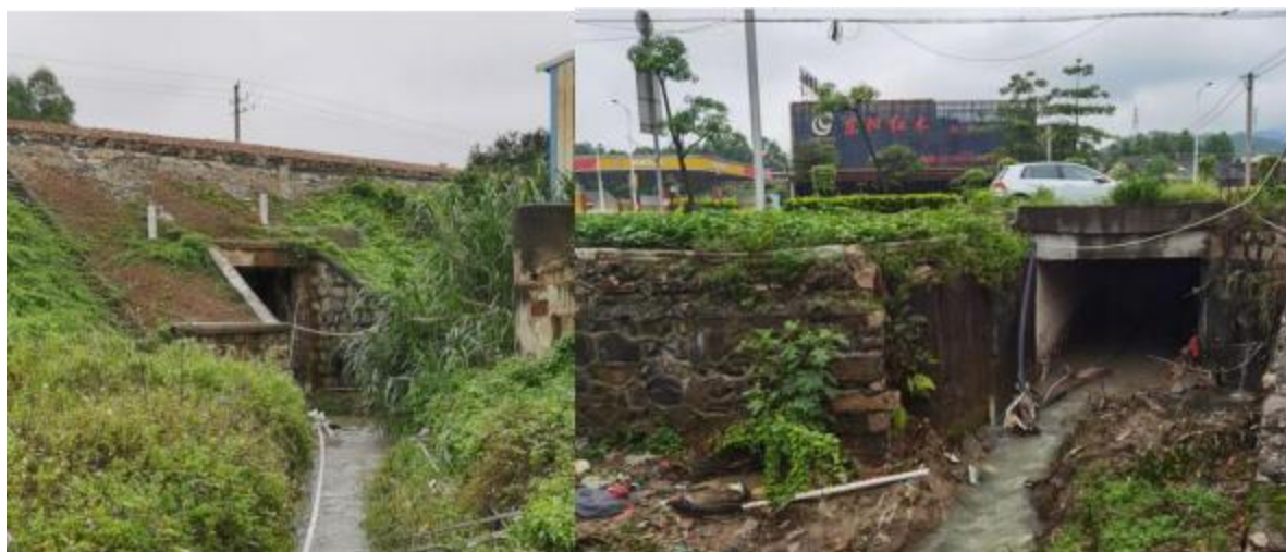
图 4.2-3 有暗涵（铁路左、国道右）的现状
